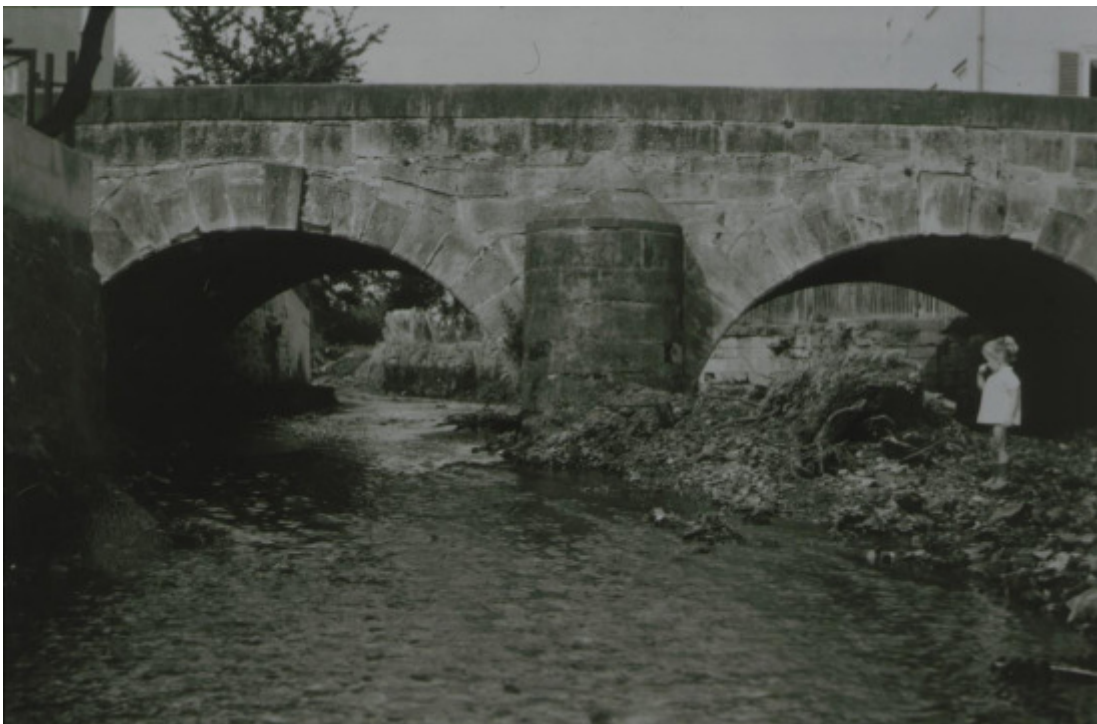
Gilsabrücke Mühlengasse (Bahnhofstr.)
