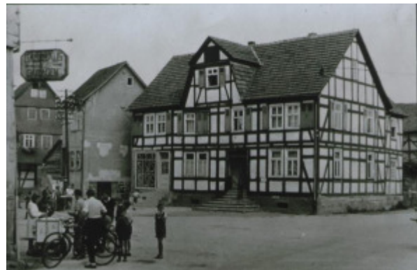
Foto aus den 50ziger Jahren, der Wappenstein befindet sich heute links neben der Treppe.
