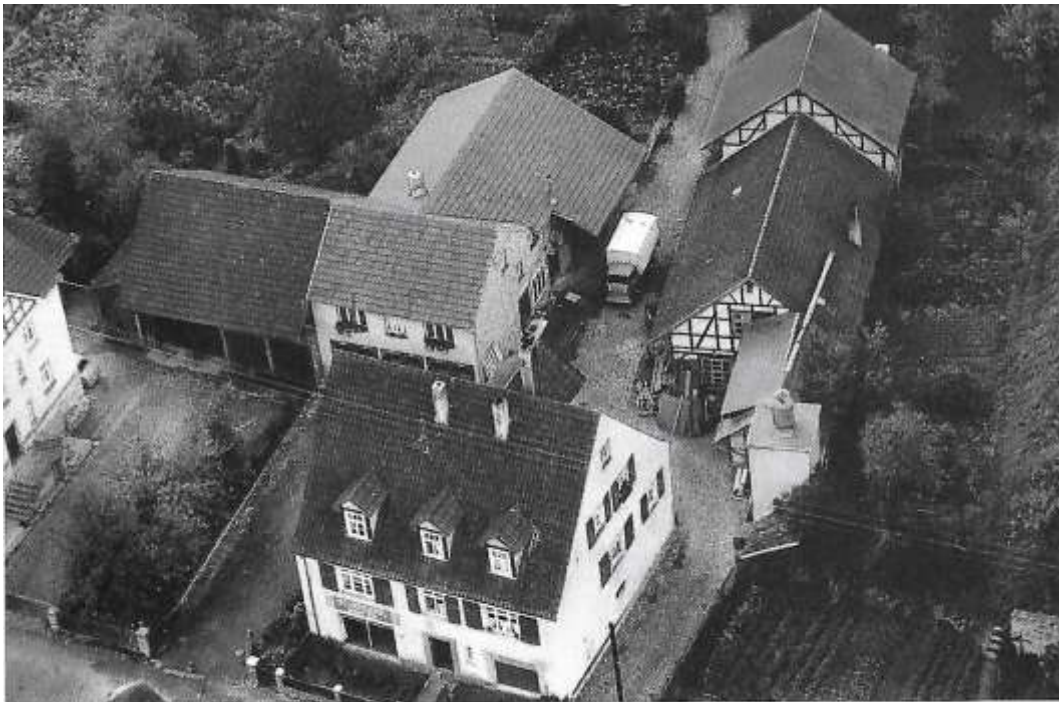
Die Gebäude der Schreinerei Böth in der Bahnhofstraße im Jahre 1956. Sie wurden 1932 von Schreinermeister August Böth gebaut, der seine Werkstatt von der Bergstraße (vgl. Seite 59) hierher verlegte.
