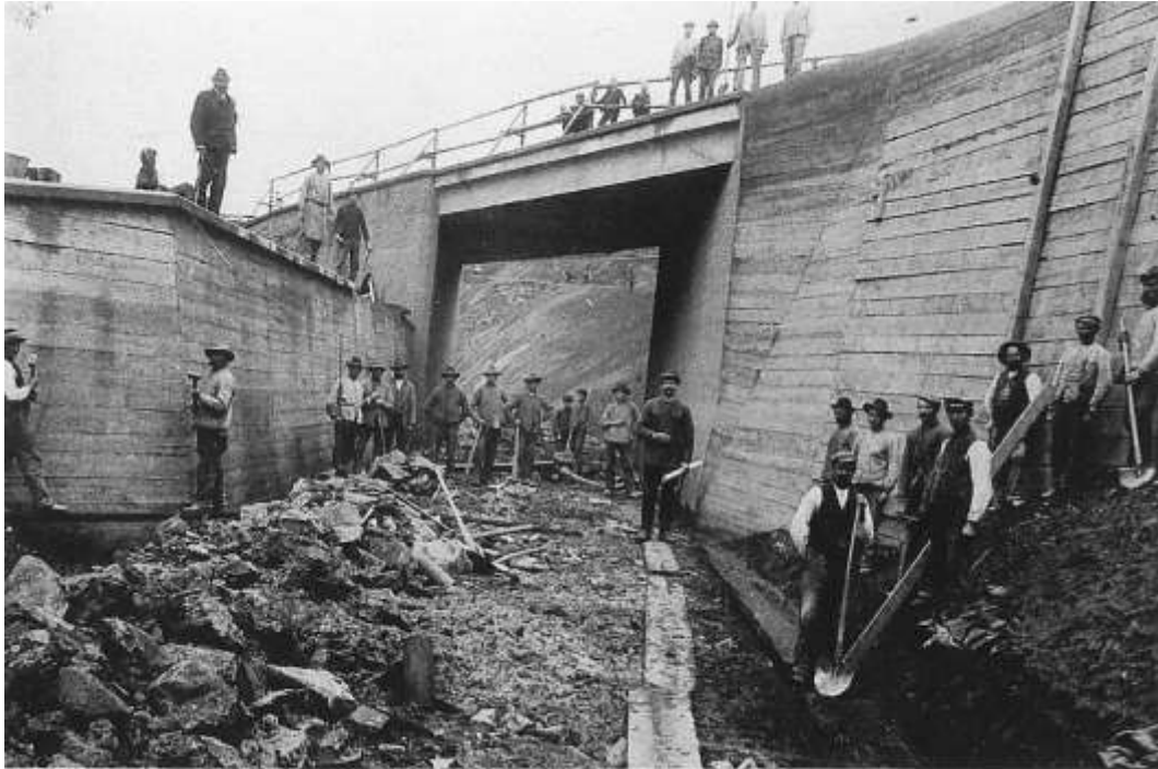
Beim Bau der Bahnlinie von Zimmersrode nach Gemünden in den Jahren 1911–1912 wurden in der Ortslage Densberg mit erheblichem Arbeitsaufwand ein tiefer Einschnitt und zwei Brücken errichtet.
