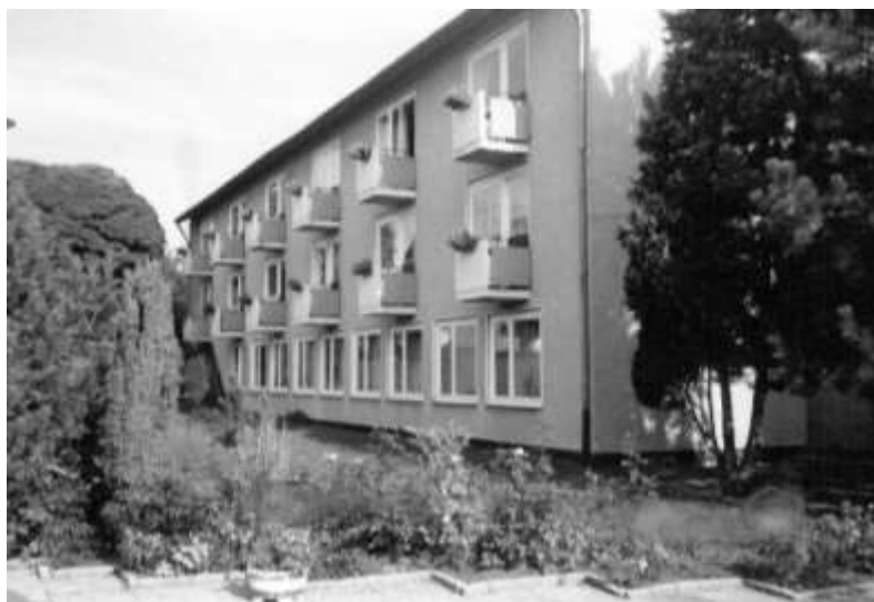
Der Neubau Altenheim
