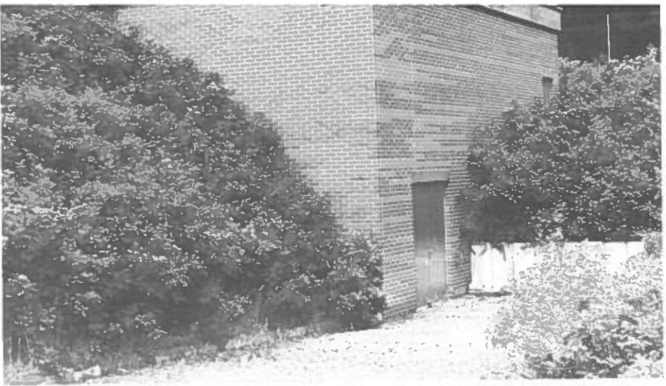
Hochbehälter (1982/83) mit Aufbereitungsanlagen im Kellerwald - zentral für Jesberg (Kern) und Densberg
