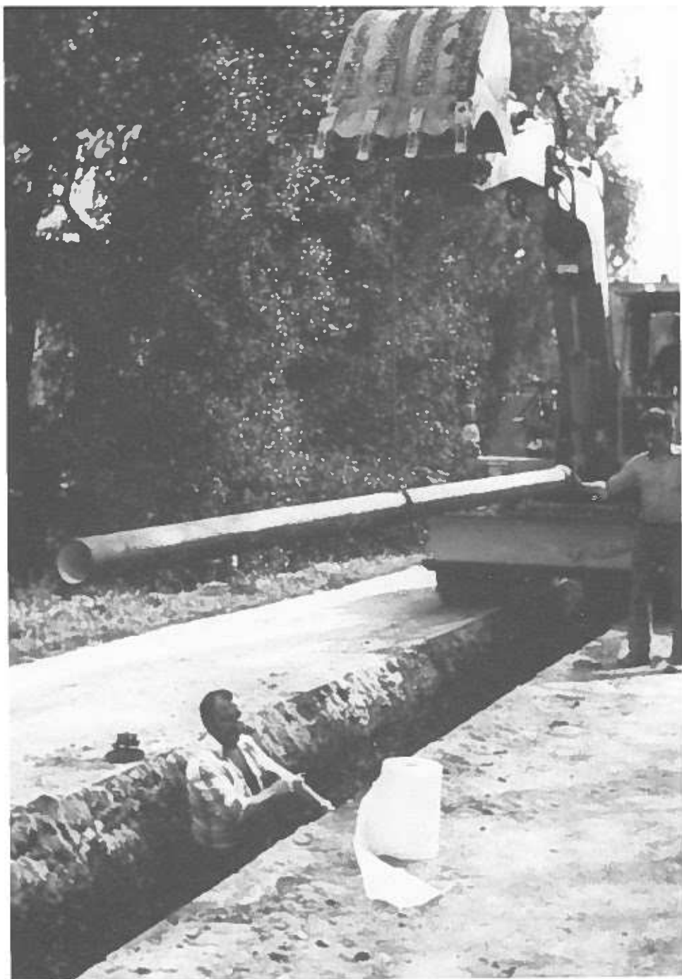
Das 6-Meter-Rohr – \varnothing 150 mm –; vorn: Rolle Schlauchisolierung
