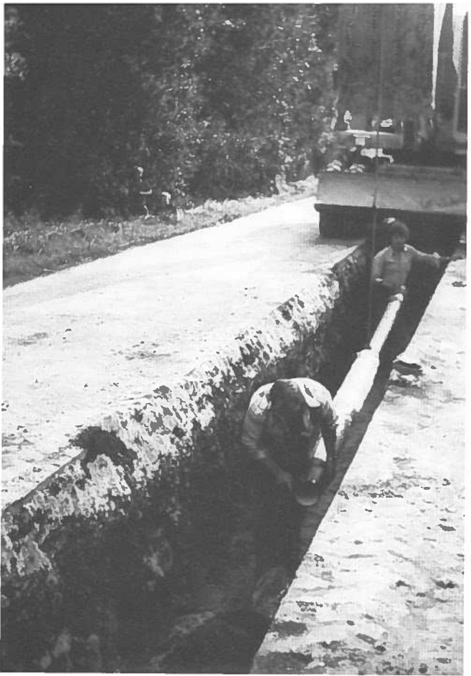
Überziehen der Schlauchisolierung
