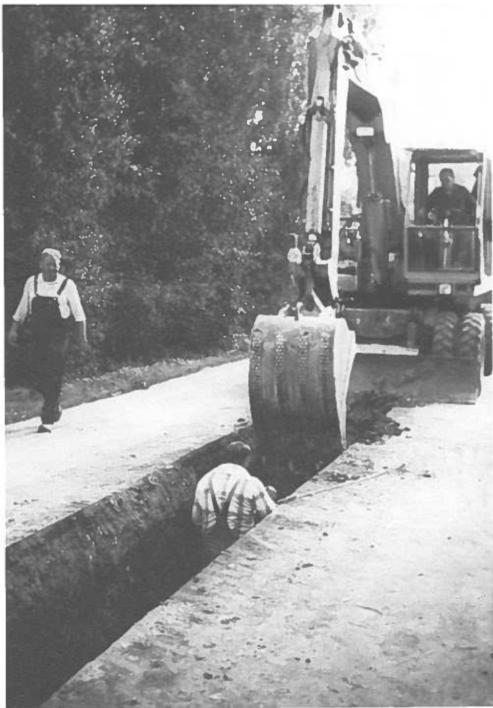
Das Ausheben des Grabens
