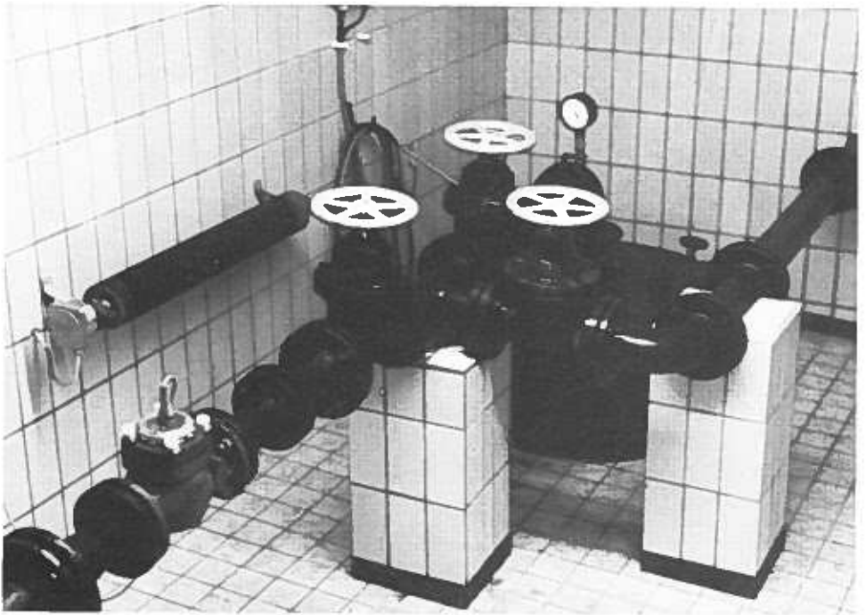
Oberer Abschluß des Tiefbrunnens - Druckleitung zum Hochbehälter und Überlauf (rechts)
