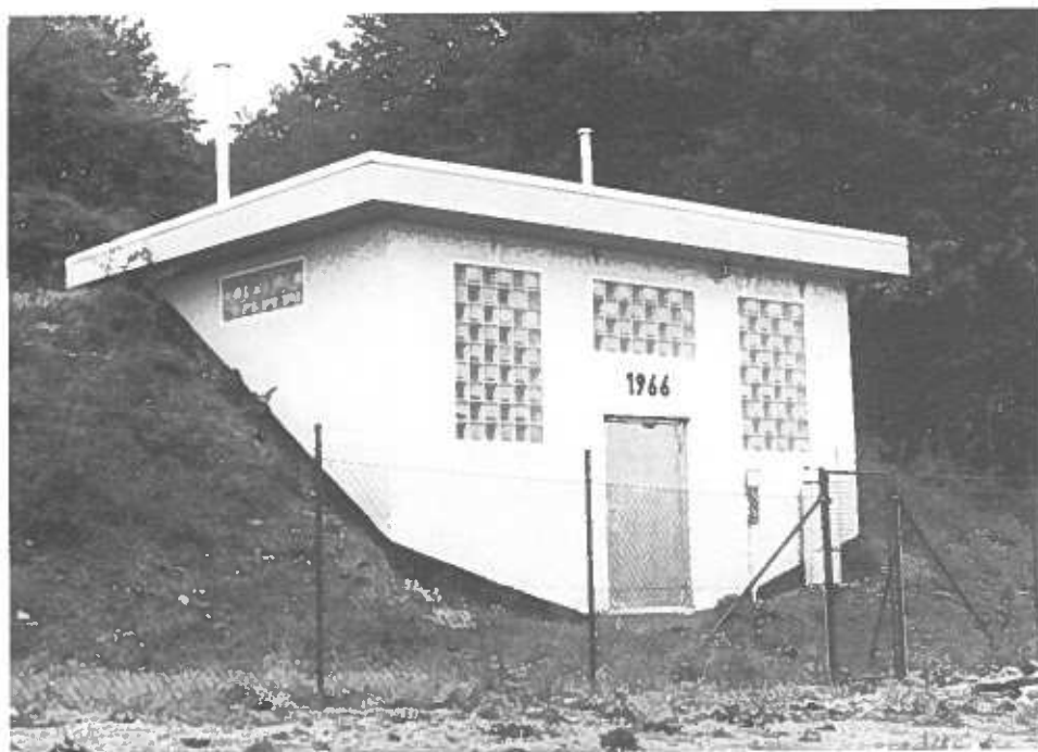
Hochbehälter (1966) am Jesberger „Küppel“ · im Verbund mit dem Hochbehälter im Kellerwald; Zuspeisung aus dem Kalkbrunnen bleibt möglich
