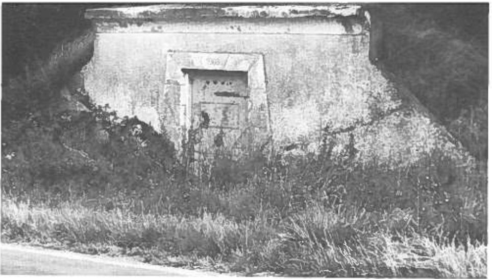
Alter Hochbehälter Hundshausen (1909) - hat nur noch die Funktion der Feuerlöschwasserreserve
