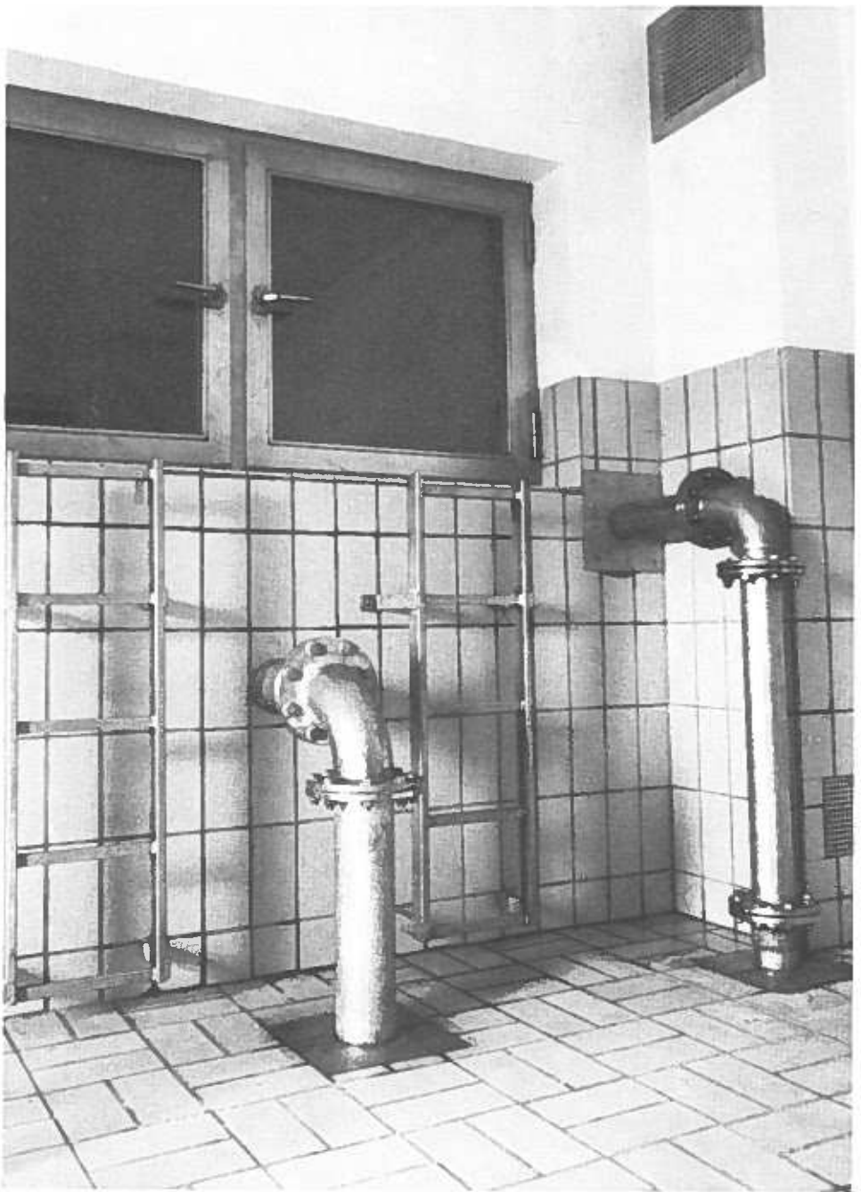
Hinter der Wand liegen die beiden neuen Wasserkammern · zusammen 150 m 3 fassend; in der Mitte zwischen den Leitern: das Abflußrohr des Überlaufs; rechts davon die Zuleitung vom Tiefbrunnen Elnrode
