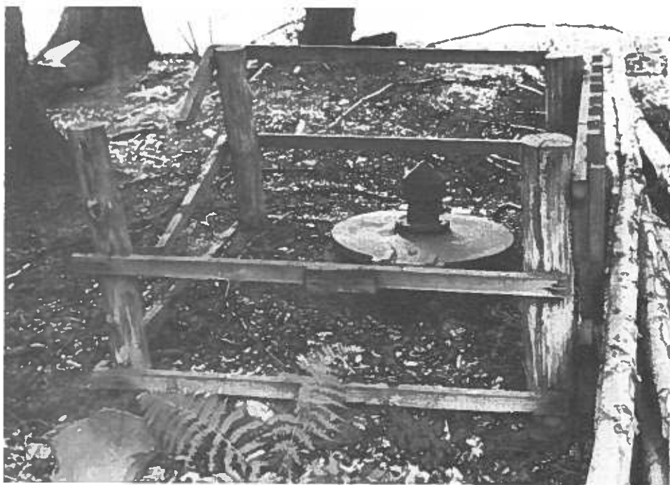
Alter Sammelschacht im Kellerwald oberhalb Brünchenhain · an der stillgelegten Falleitung
