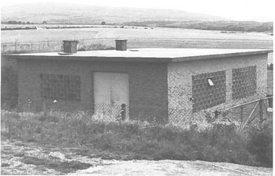
Hochbehälter von Reptich mit Pumpstation
