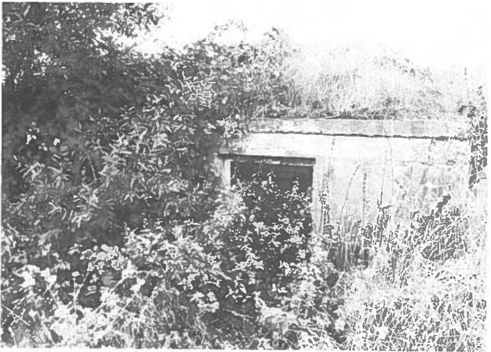
Alter Hochbehälter und ehem. Pumpstation zwischen Siedlung und Siedlerquelle
