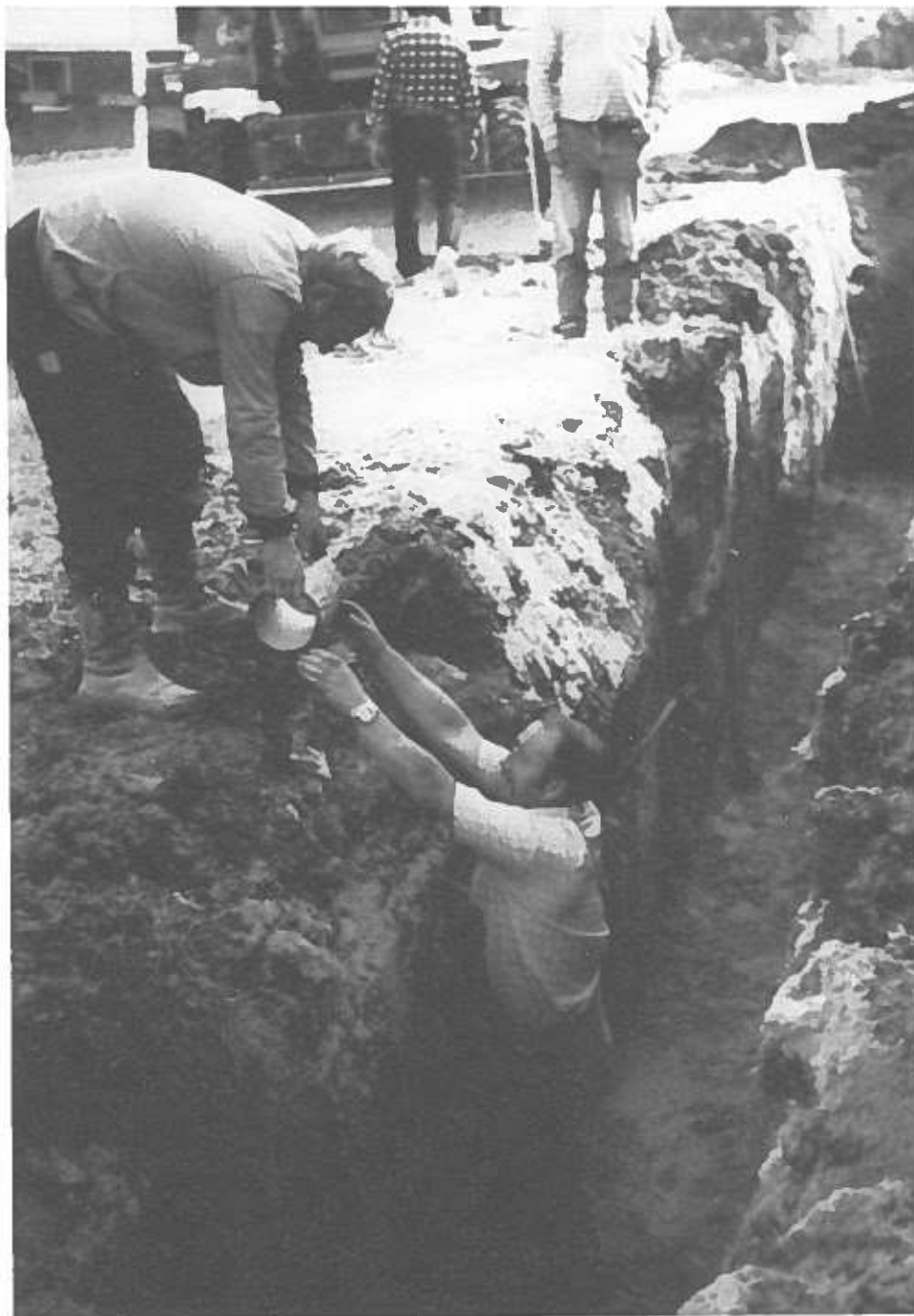
Im Graben von 1,50 m Tiefe werden die Rohre verlegt (hier: Anschlußstück; Dorfstraße bei Pauls)
