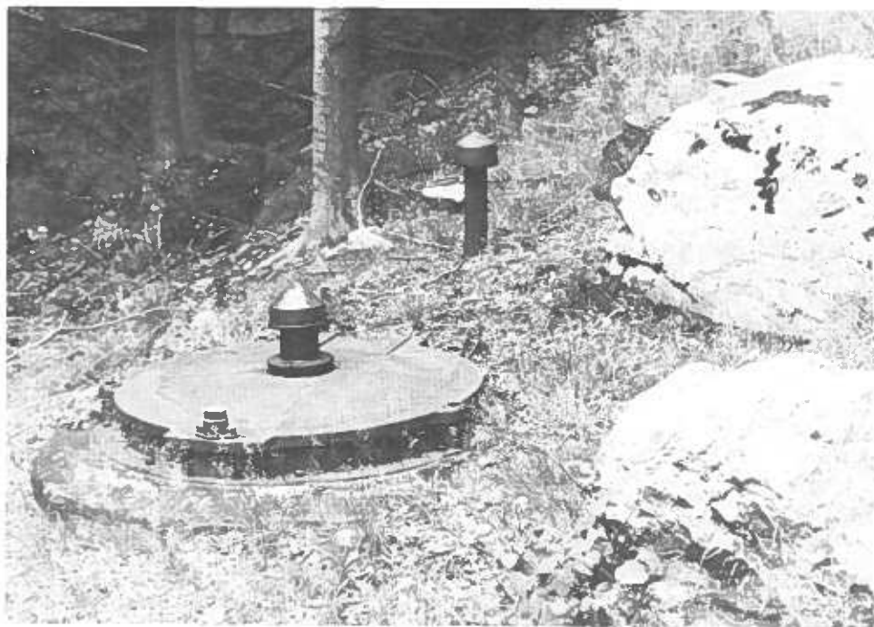
Durchlauf der beiden Jesberger Kellerwaldquellen im Schieferrains-Graben
