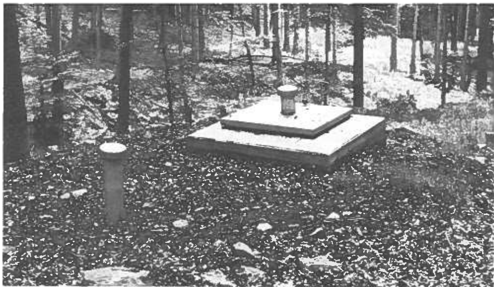
Quellsammelschacht im Schieferrains-Graben
