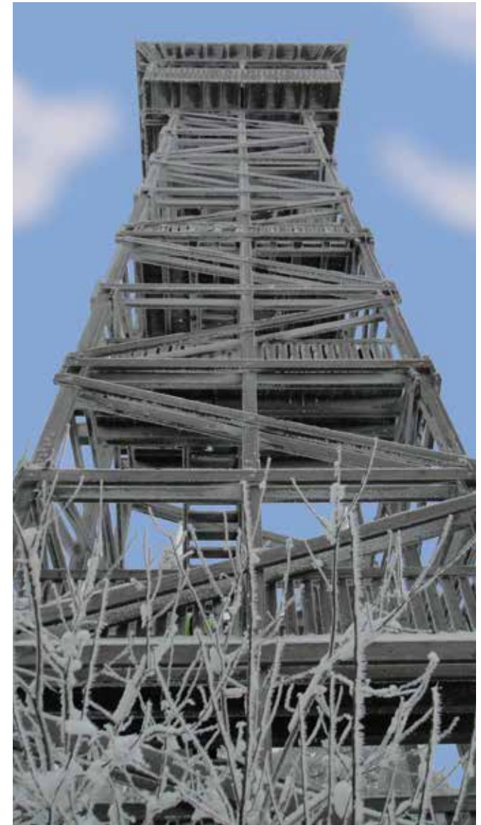
Kellerwaldturm, mit 25m hoher Aussichtsplattform
